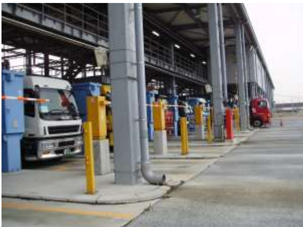
写真-1 集中管理ゲートの外観
