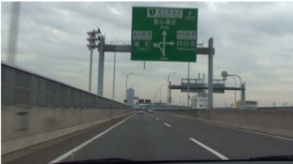
写真-2 図形タイプ標識 (600m 手前)
