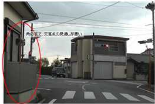
図-10 三重県道60号前野交差点付近の様子
