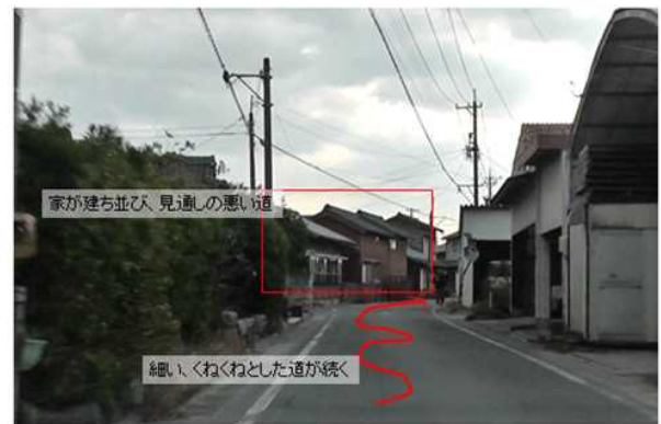
図-12 三重県道60号大宮田町付近の様子
