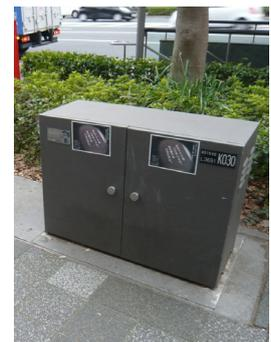
写真-5 電線地中化用機器
