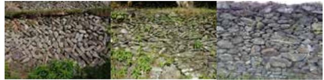
図-8 石積みの外観(左から矢の羽積み、乱積み1、乱積み2)
