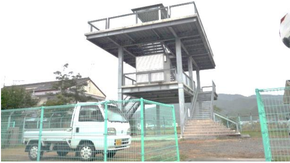
図-8 現在地区にある避難タワー
