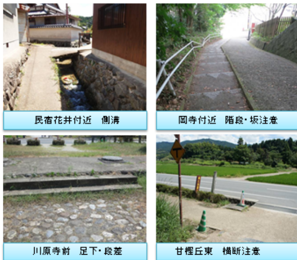
図-1 明日香村地区における通行注意箇所の例
