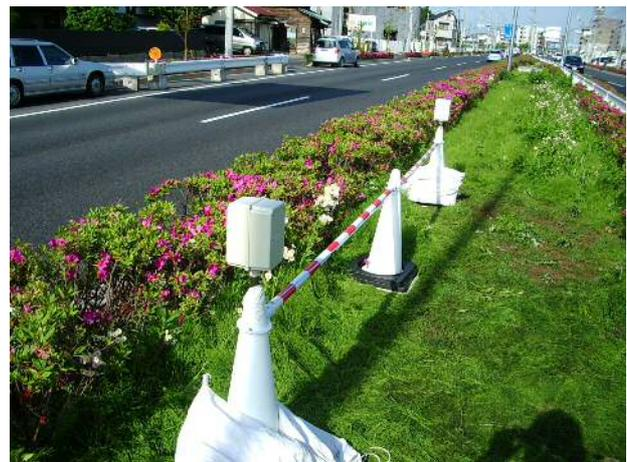
写真-2 コーン設置事例
