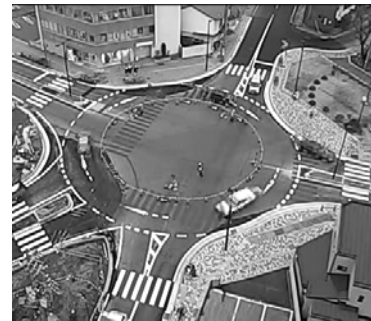
図-7 制御方式切替直後の状況
