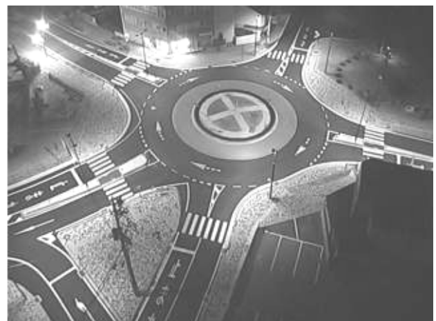
図-3 ラウンドアバウト完成時の形態（飯田CATVwebカメラより）
