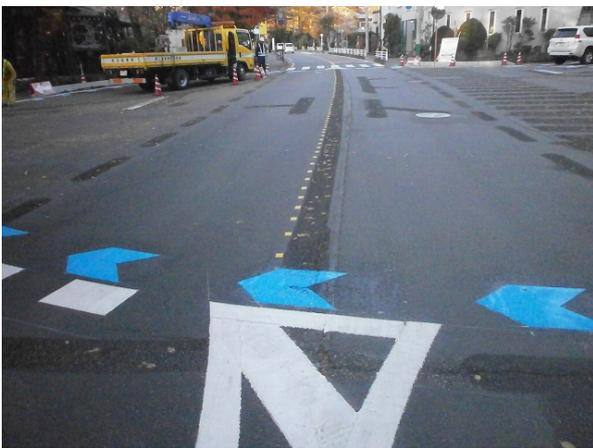
図ー4 ウォータージェット工法による路面標示消去例
