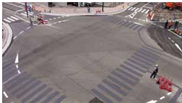
写真-10 暫定ラウンドアバウトの切り替え 1
