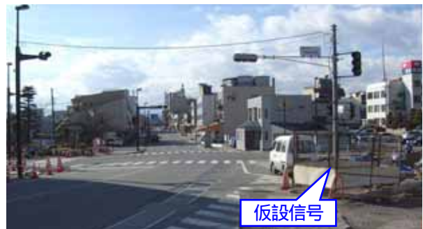
写真-5 信号の移設（移設後）
