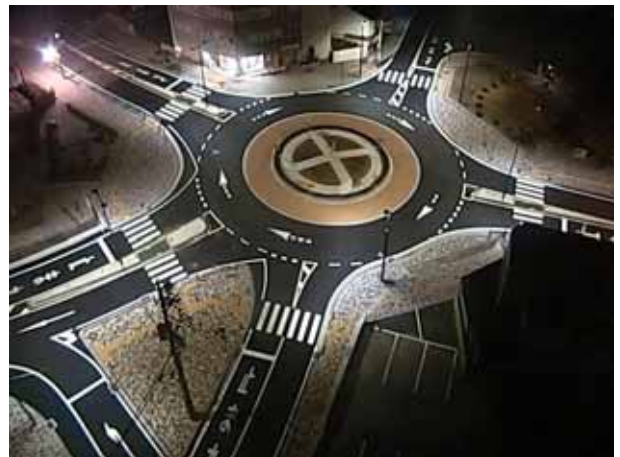
写真-15 施工後の状況1 飯田CATVwebカメラより
