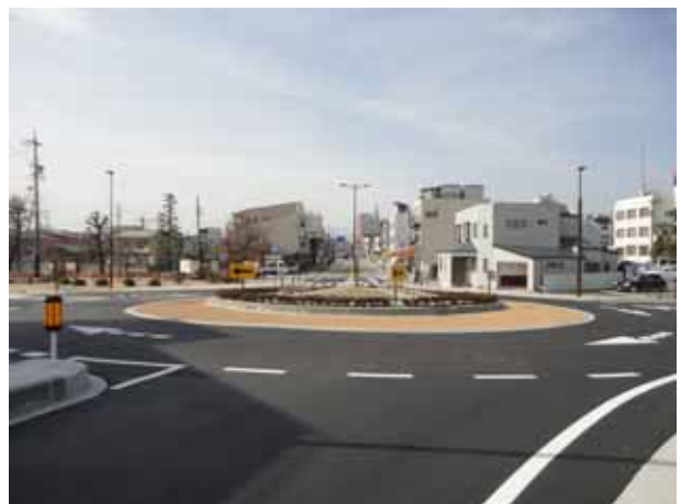
写真-16 施工後の状況2
