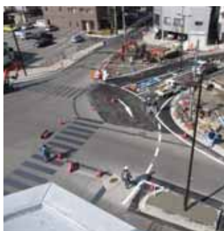
写真-8 区画線の消去と設置
