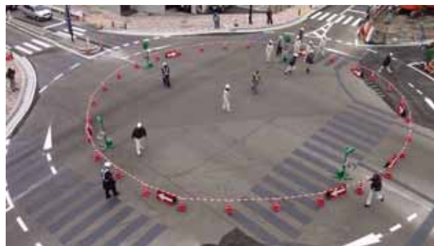
写真-12 暫定ラウンドアバウトの切り替え 3
