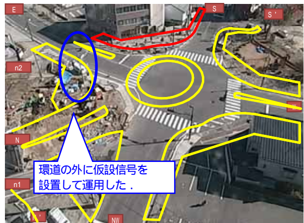
写真-4 信号の移設（移設後） 飯田 CATVweb カメラより
