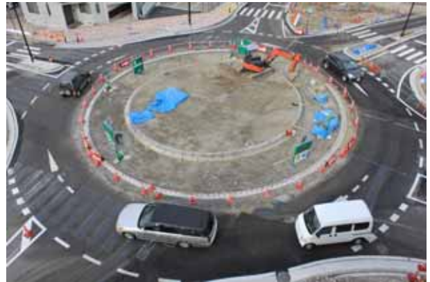
写真-14 中央部の施工
