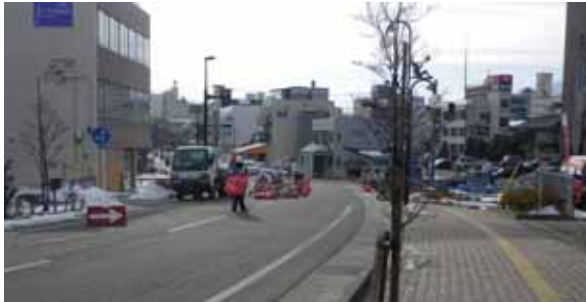
写真-1 片側交互通行，交通誘導員の配置
