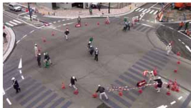
写真-11 暫定ラウンドアバウトの切り替え 2
