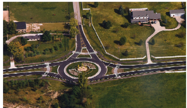
写真-1 郊外部に設置された小型1車線ラウンドアバウト
