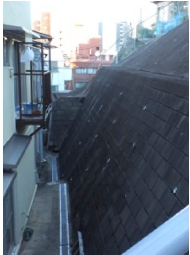
図4 赤城元町コンクリート覆工(筆者撮影)
