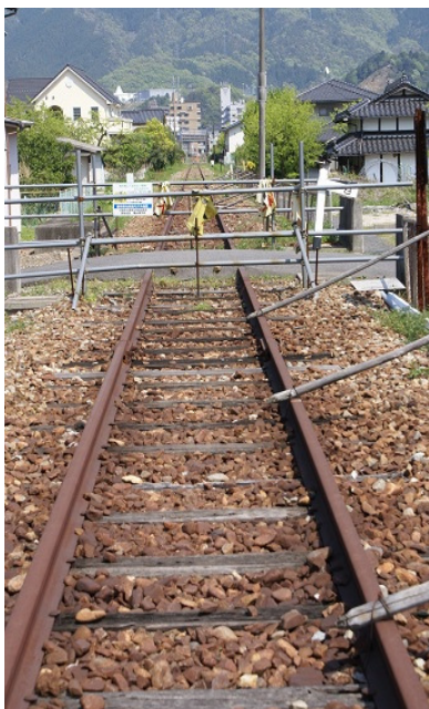
写真2 廃止後もレールや枕木、バラストなどが残ったままの可部～河戸間
