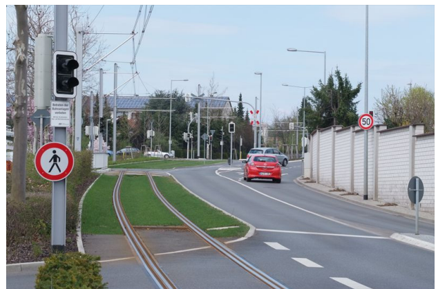
写真6 単線区間（左）と歩道を撤去し新設した壁（右）
