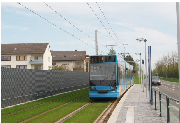
写真7 住宅地との境界に設けられた壁と緑化軌道
