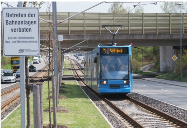
写真3 連邦道中央の緑地帯と左側通行区間
