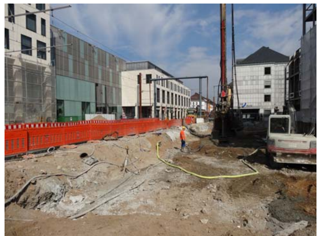
写真-1 カール通りの工事現場（2012年9月5日撮影）
