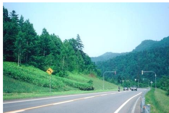
写真-3 切土法面の緩勾配化による安全性と景観性を高めている事例
