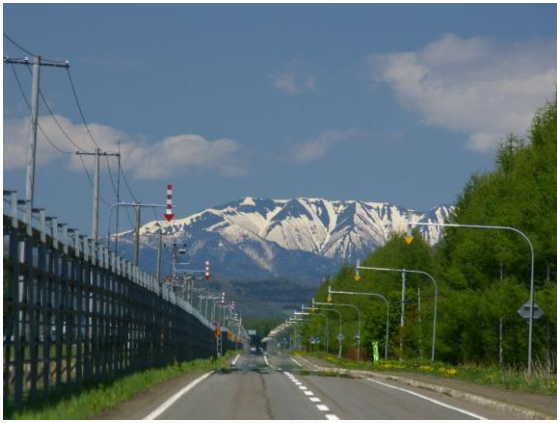
写真-2 背景の魅力的な景観を阻害することもある道路施設
