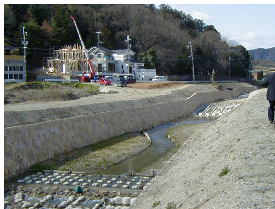
図-4 初期段階の整備での板柵工によるみお筋の固定化
