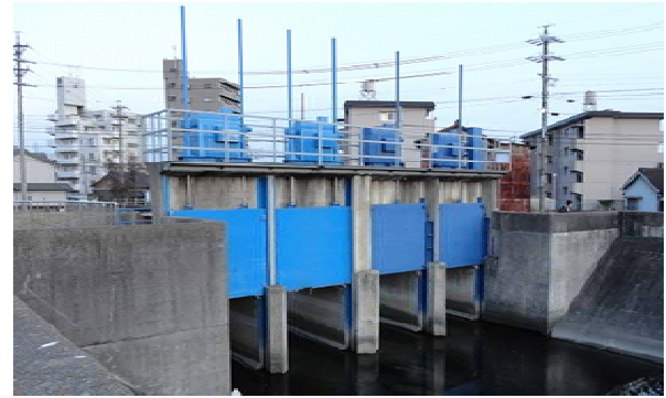
写真-1 伊勢湾台風高潮対策事業によって建設された樋門（昭和38年竣工）
