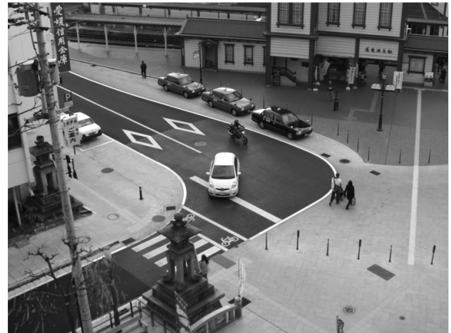
図-2 撮影対象エリア 整備後
