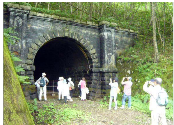
図4 新内隧道の見学
