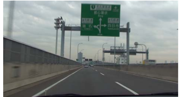
写真-2 図形タイプ標識(600m 手前)
