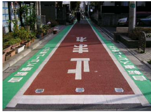
写真-8 路肩を緑色でカラー化した整備事例
