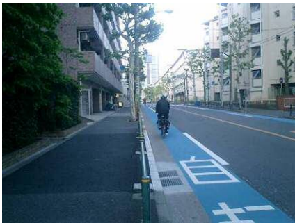
写真-6 路肩を青色でカラー化して自転車レーンとして採用した事例（東京都渋谷区幡ヶ谷駅付近）
