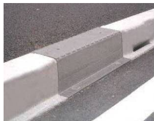
図-8 導水ブロック詳細構造図 (株トヨキョー提供)
