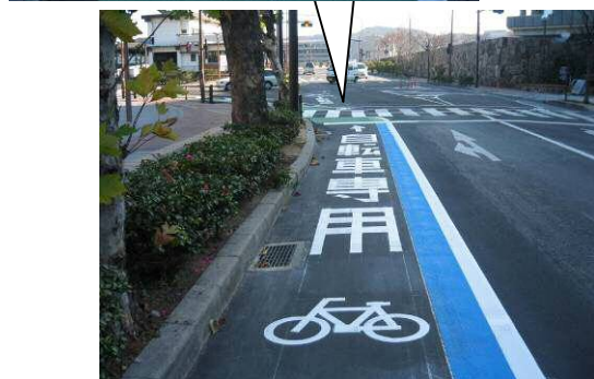
写真-17 自転車専用レーン実線（青）のみ標示 交差点部は全面着色（緑）した事例（岡山県庁前）
