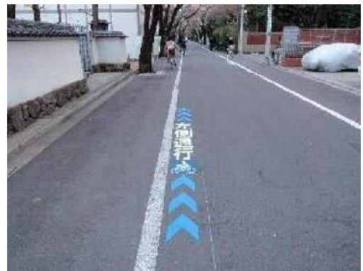
写真-14 路面標示「自転車左側通行」(世田谷区成城6丁目付近, 出典: 世田谷区HP)
