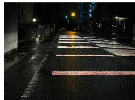
写真-1 滑りにくい構造を用いた事例（県道西宮豊中線 兵庫県西宮市松並町付近）
