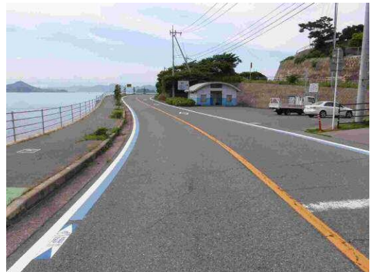
写真-4 車道左側部のカラー舗装化の整備事例 (尾道市瀬戸田町生口島地内 しまなみ海道)
