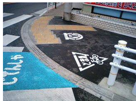
写真-20 交差点における導水ブロックの設置
