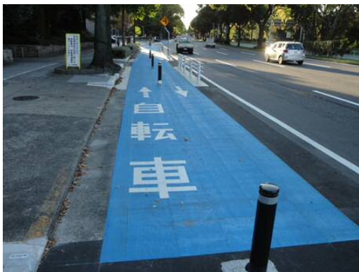
写真-2 自転車道の整備事例 1 (名古屋市中区地内)
