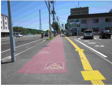
写真-12 自転車通行部にベンガラ色を採用した事例2 (北海道江別市 JR大森駅付近)
