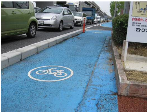
写真-23 奈良県奈良市地区の整備事例 (株イトーヨーギョー提供)
