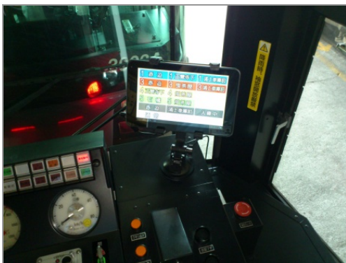
図-23 5001号車の機器設置風景
