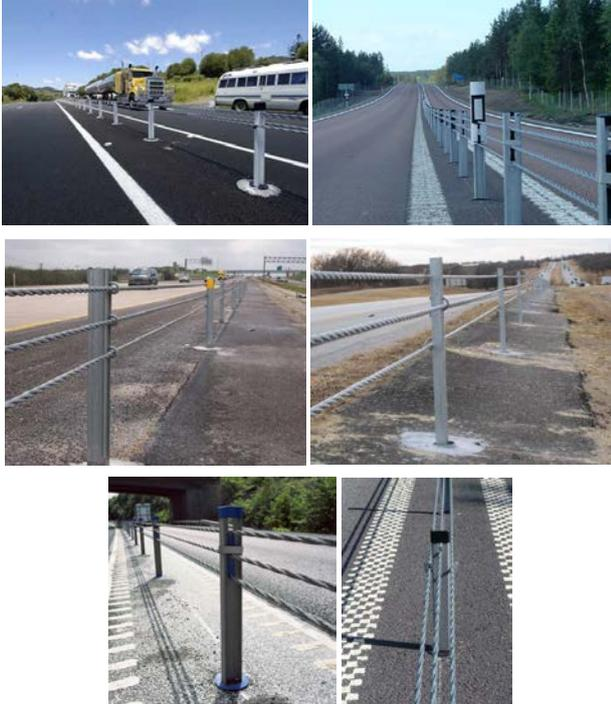
写真-6 各社のワイヤーロープ式防護柵；Brifen社<sup>9)</sup>(左上)、Trinity社(右上)、Gibraltar社<sup>9)</sup>(左中)、Nucor社<sup>9)</sup>(右中)、Blue System社<sup>9)</sup>(左下)、Gunnebo社<sup>9)</sup>(右下)
