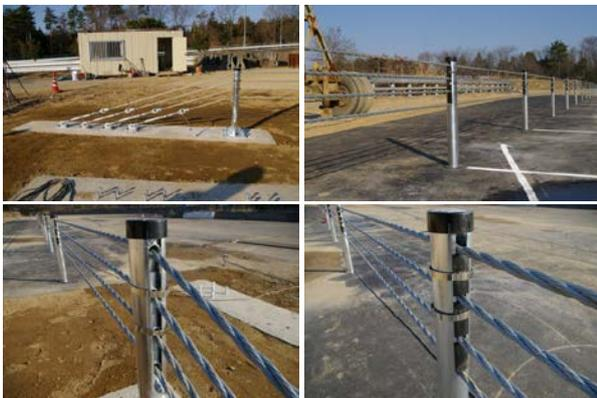
写真-15 分離帯用Am種の試作品 (左上: 端末, 右上: 中間部, 左下: 端末支柱, 右下: 中間支柱)
