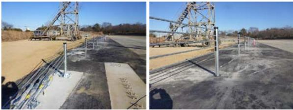
写真-22 防護柵設置状況
