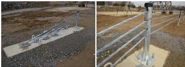
写真-11 末端基礎と末端支柱の形状
