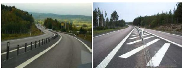
写真-3 ワイヤーロープ式防護柵付きの2+1車線道路 (スウェーデン)
