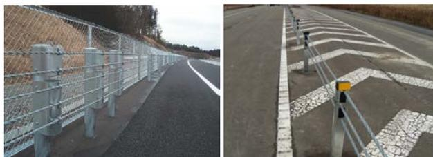
写真-2 ガードケーブル (左) とワイヤーロープ式防護柵 (右)
