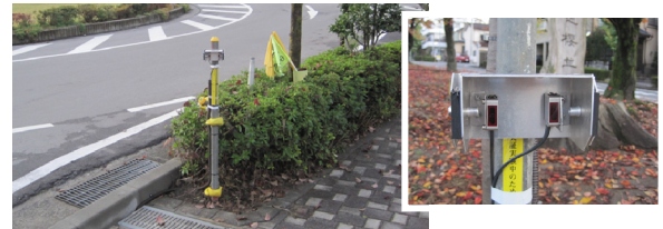
図-4 センサ柱の設置状況と検出部
