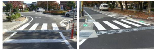
(a) 北側流入部 (b) 北側流出部
