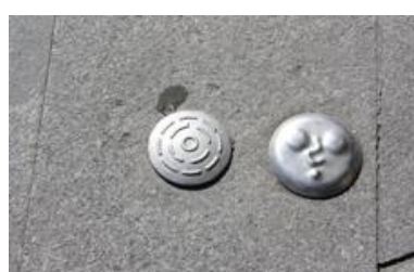
セビリア、LRT、自転車道の境界を示す
