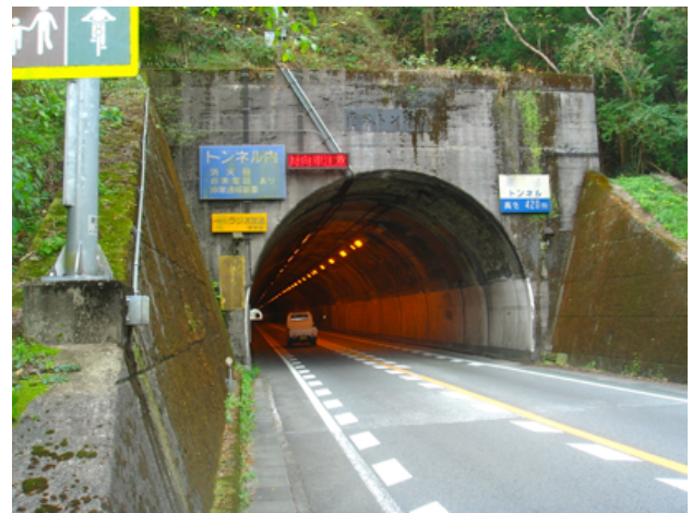
図-1 ケーススタディとしたトンネルの写真
