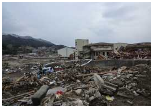
図 2 2 越喜来小学校の被害 (2)
