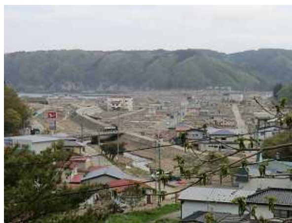
図18 甚大な被害を受けた田老町の全景
