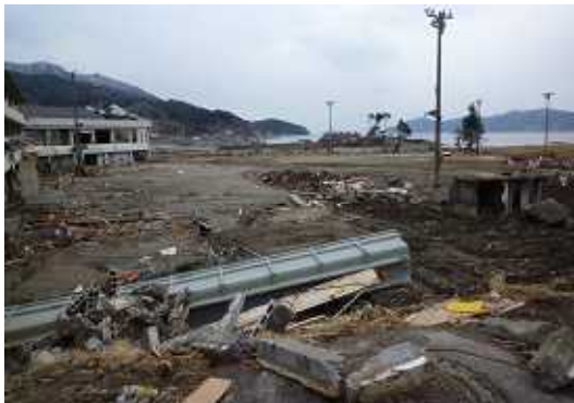
図 2 1 越喜来小学校の被害 (1)
