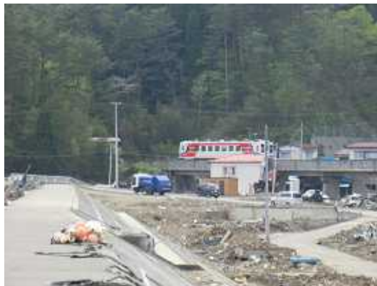
図16 田老駅(橋梁部)
