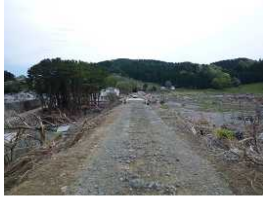
図 2 0 三陸駅付近の被害
