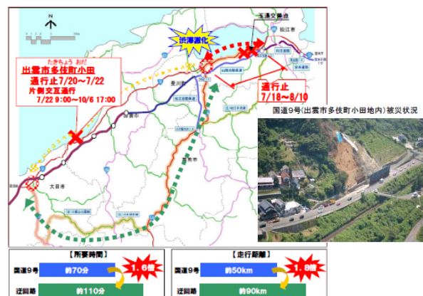
図-6 山陰地方の災害発生時の例(平成18年7月豪雨災害) 4)
