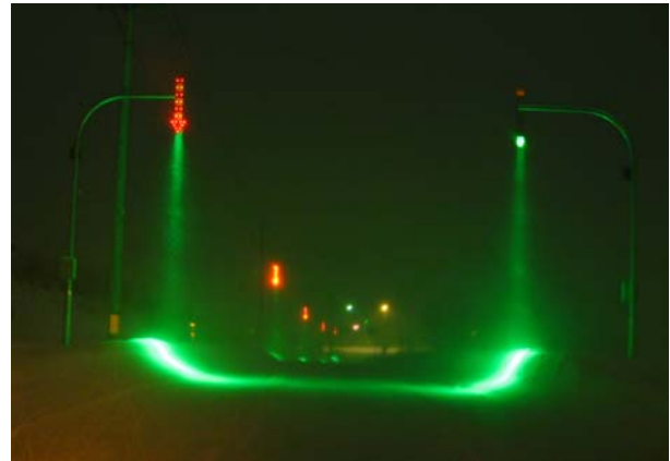
写真3 現道での点灯状況 (降雪時の柱状の光の形成)
