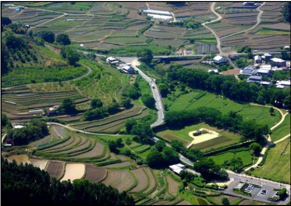
図-7 現況航空写真
