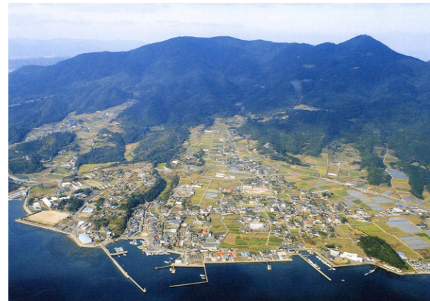
写真-7 棚底の航空写真（平成20年撮影）
