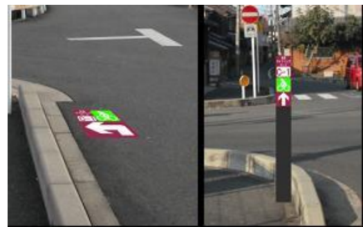
図-4 案内サイン(路面型, 柱型)
