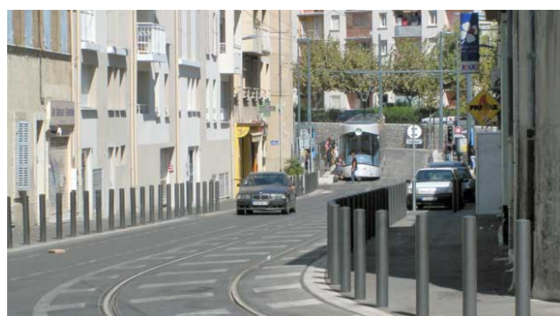
写真-4 狭い街路に敷設された例 (マルセイユ市内)
