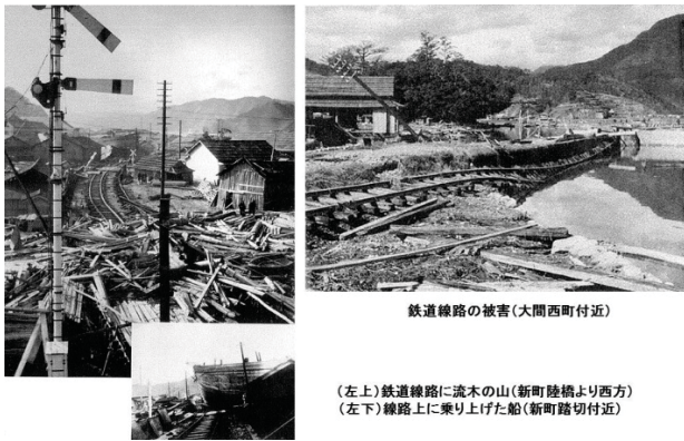
図-1 南海地震津波による鉄道被害の例
