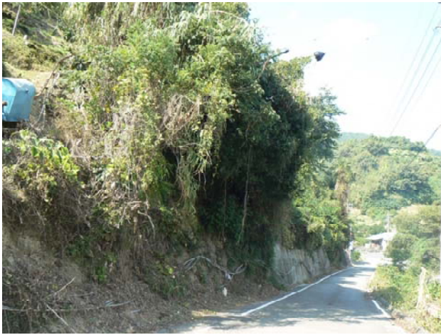
図-10 土砂災害避難経路阻害箇所
