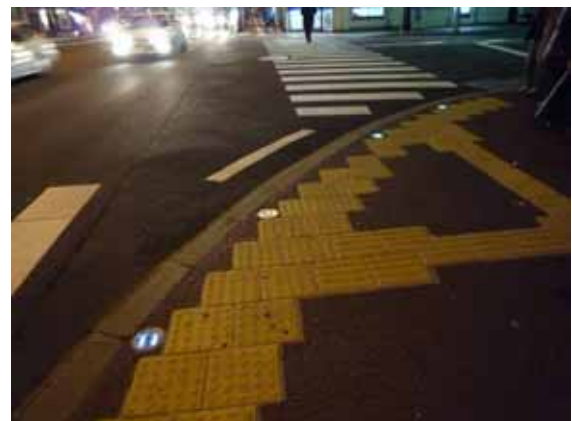
写真-3 交差点設置状況
