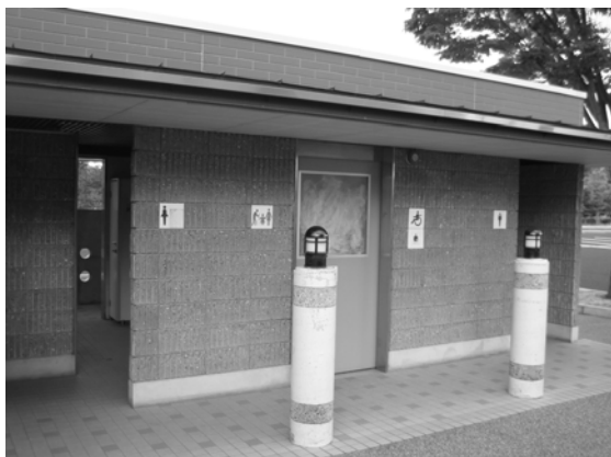
図-2 バス停隣接トイレの例(津山市役所周辺)
