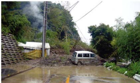
写真一 土砂崩れによる寸断された状況
