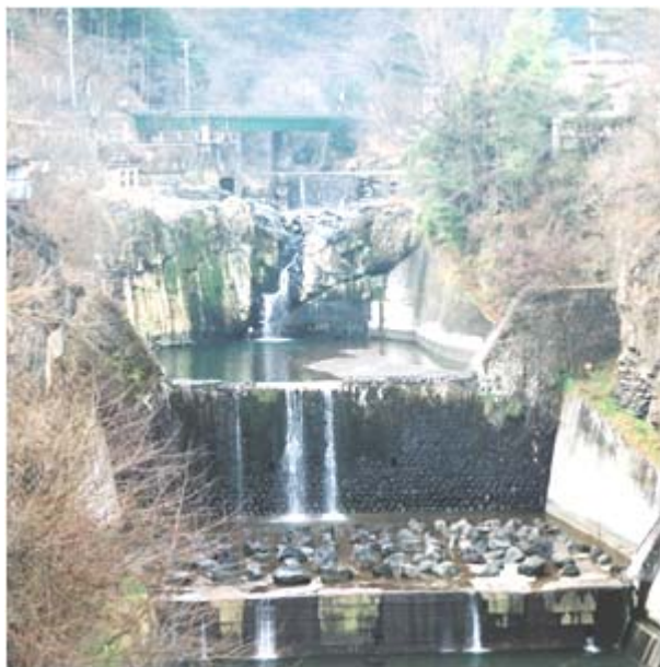
写真2 昭和33年に設置された砂防堰堤
