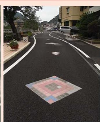
地(アスファルト)に対して図になる舗装の図案、色を考えた。その際、場所によって配色や大きさを変化させ、動きをつけた。また大きすぎると、図として認識されないので、歩く人の目線を考え、ヒューマンスケールに配慮した。また横軸方向に対して図となる線状の帯を入れ、車両の速度を抑制することも狙った。
