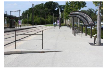
ルマン、停留所での駐輪場シェルター
