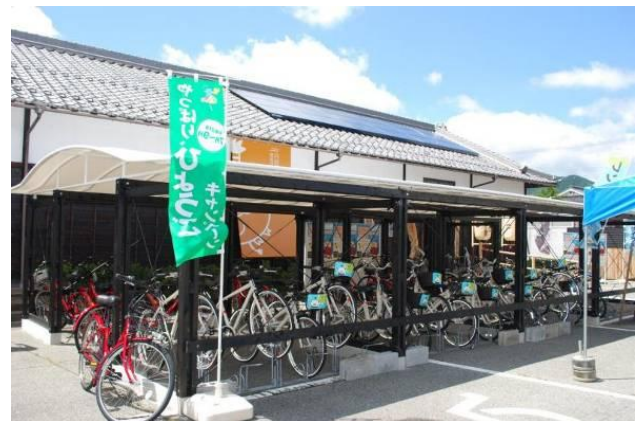
写真-2 大手前展示館サイクルポート (屋根に太陽光パネルが設置されている)
