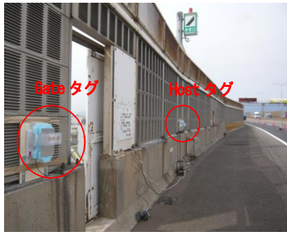
図-1 橋梁側の設置状況(パッシブRFID)
