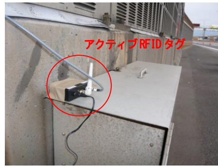
図-2 橋梁側の設置状況(アクティブRFID)
