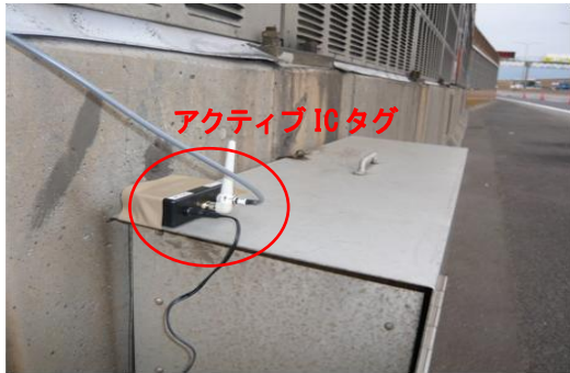
図-2 橋梁側の設置状況
