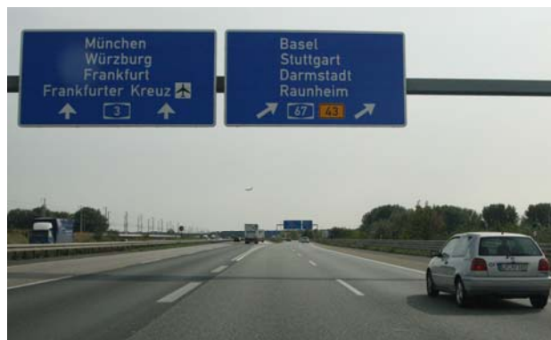
写真-1 骨格案内ができていない事例(フランクフルト)
