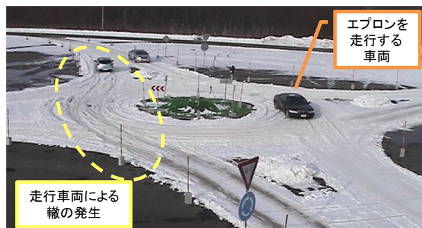
写真-2 走行車両による轍の発生とエプロン走行車両
