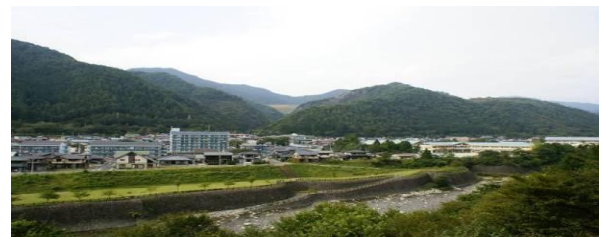
図-4 バイパス道路から箕ノ子橋堆積場
