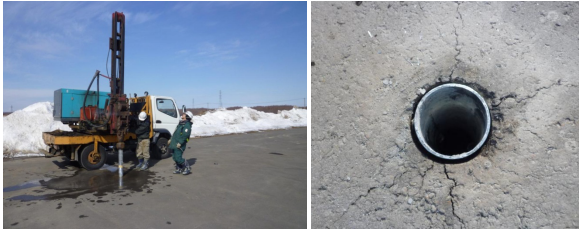
写真-9 支柱基礎の試験施工状況と施工結果
