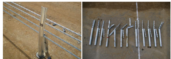
写真-8 衝突後の支柱の破損状況
