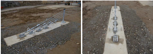
写真-6 ワイヤー端部と基礎の形状
